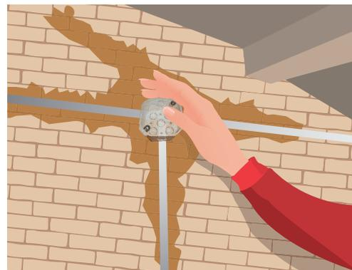
**Tendido de alambre por los ductos, desde la caja principal hasta el último punto de instalación del domicilio y derivaciones para cada punto de energía en conexión.**
